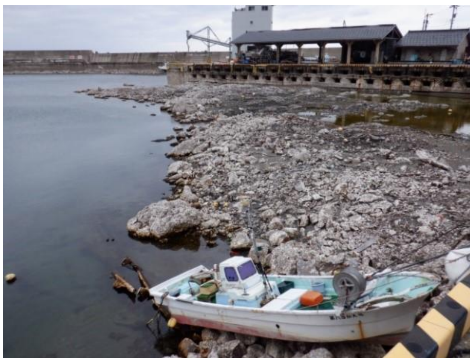
地震により大きく隆起した鹿磯漁港（2024年3月）
