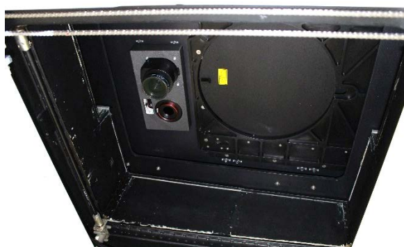
写真9 測深機搭載状態の開口部
