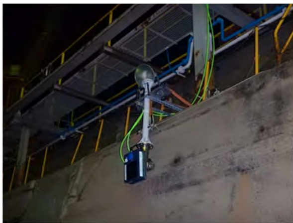
図4 3D ソナー設置状況
