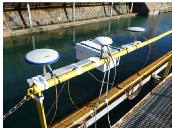
図5 GNSS 設置状況
