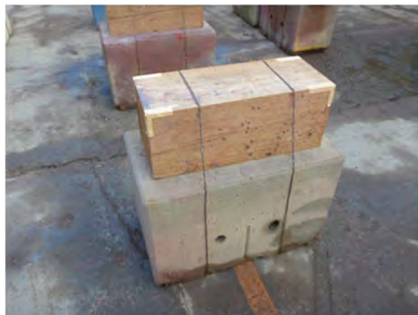
図6 盤木設置状況
