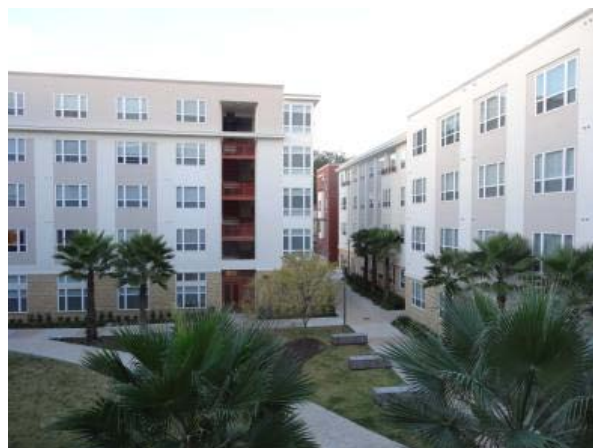
写真4 アパート外観
