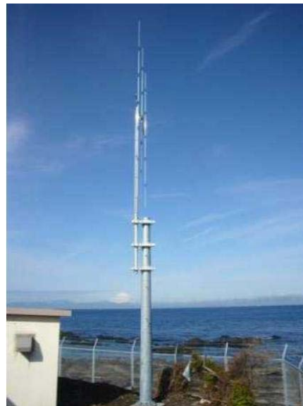
写真 伊豆大島灯台及び荒崎に設置された海洋短波レーダーのアンテナ
