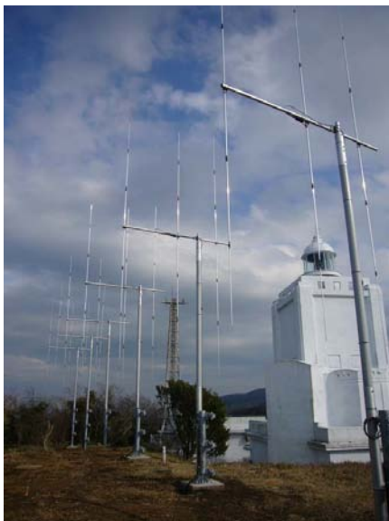
写真 伊豆大島灯台及び荒崎に設置された海洋短波レーダーのアンテナ
