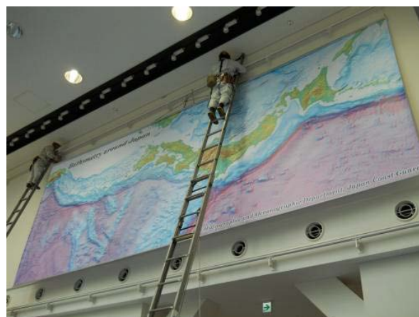
3D 海底地形図設置作業の様子
