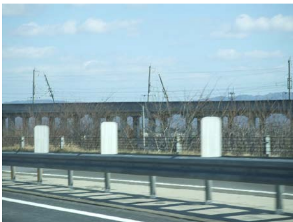
写真2 東北新幹線における架線の電柱折損状況
