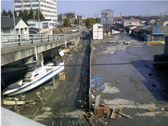
写真4 二本部庁舎周辺の状況
