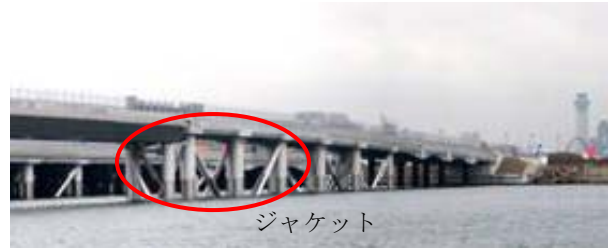
写真3 計測場所（ジャケット）
