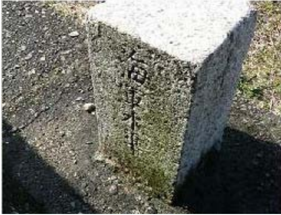
写真5 昭和12年に三重県宇治山田港に設置された海軍水準と刻んだHBM (上西勝也氏提供)
