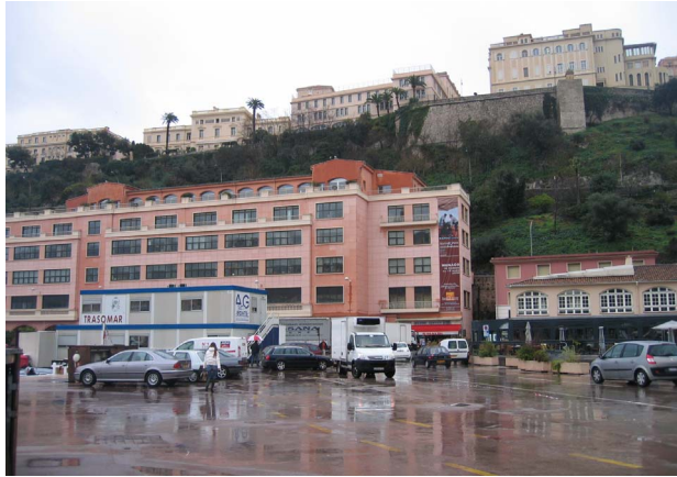
写真2 IHBの入っているビル (右手の建物がラスカス (レストラン))
