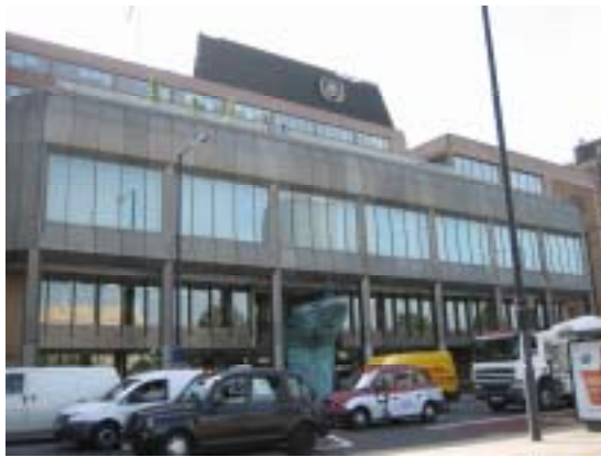
写真1 IMO本部の建物
