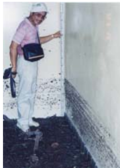
写真3 基準面から約3mの高潮痕跡
