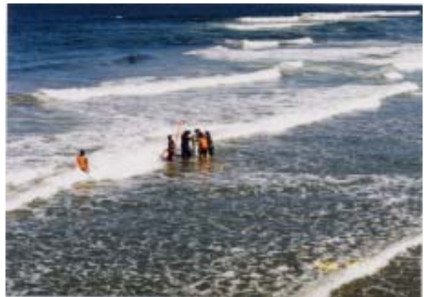
写真6 砕波帯での打設作業風景
