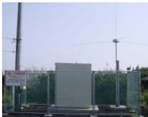
写真1 受信アンテナと観測局舎
