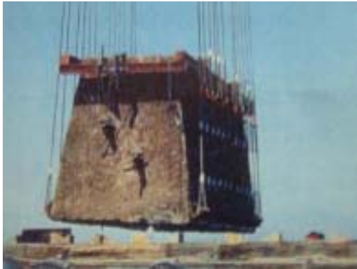
写真 7 引上げられるケーソン
