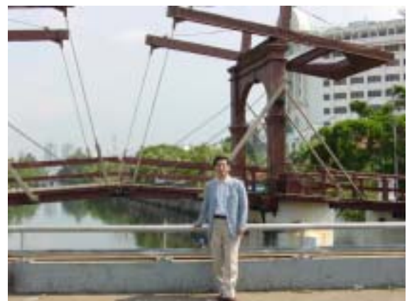
写真2 ジャカルタ北部のバタピア地区にある跳ね橋
