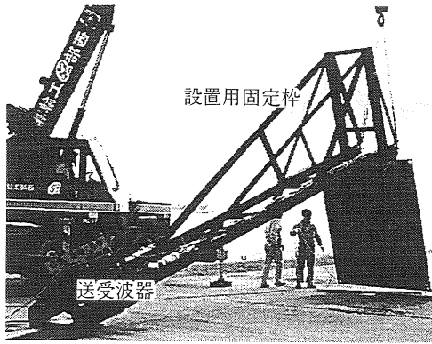
写真1 水平ドプラ式流況分布測定装置設置風景 バーにより海中で行われた。送受波器は水平面内では岸壁の面に対して30度傾けて取り付けられたので図4に示す範囲が計測範囲となる。
