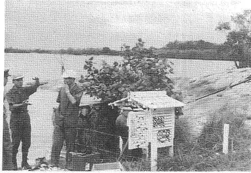
写真1 マレー半島に設置した験潮所
